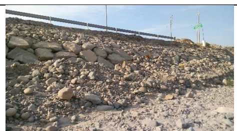
Figura 8. Defensa ribereña con enrocados.
