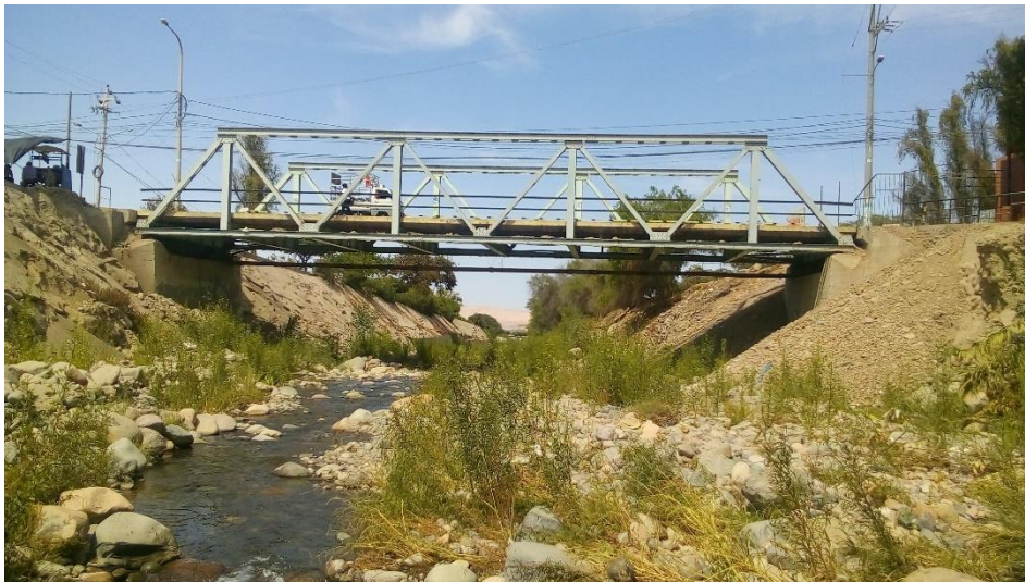
Figura 14. Vista general del Puente “la Villa”.
