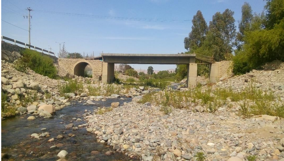
Figura 12. Puente “El Rosal”
