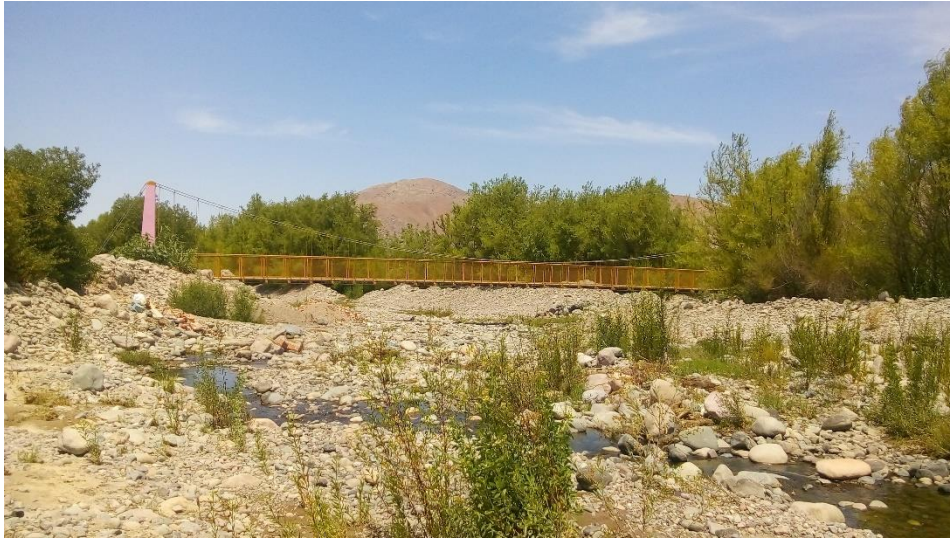
Figura 16. Vista general del Puente "Rosado".
