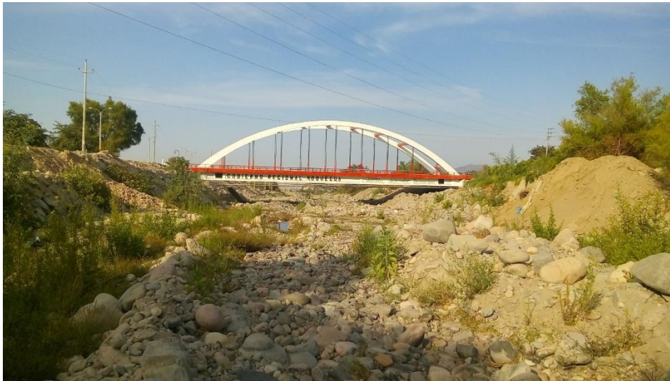
Figura 11. Puente “Samegua los Ángeles”
