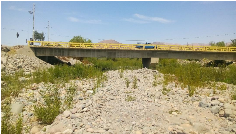
Figura 15. Vista general del Puente “El Rayo”.
