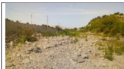
Figura 7. Defensa ribereña con muros de Concreto Armado.
