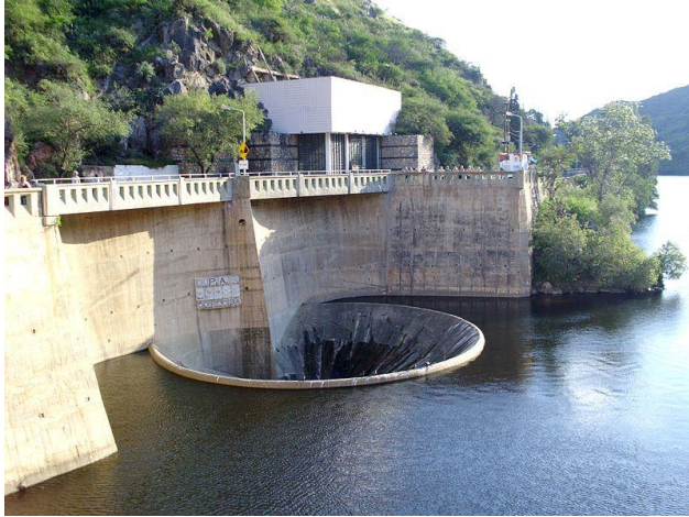
Figura 8. Aliviadero tipo orificio de la represa Dique San Roque, en Córdoba, Argentina
