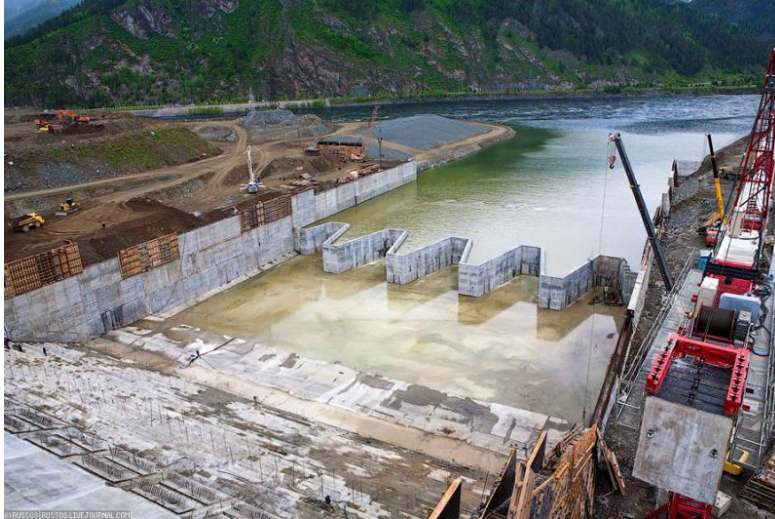
Figura 9. Aliviadero tipo laberinto de Presa Sayano-Shusenskaya
