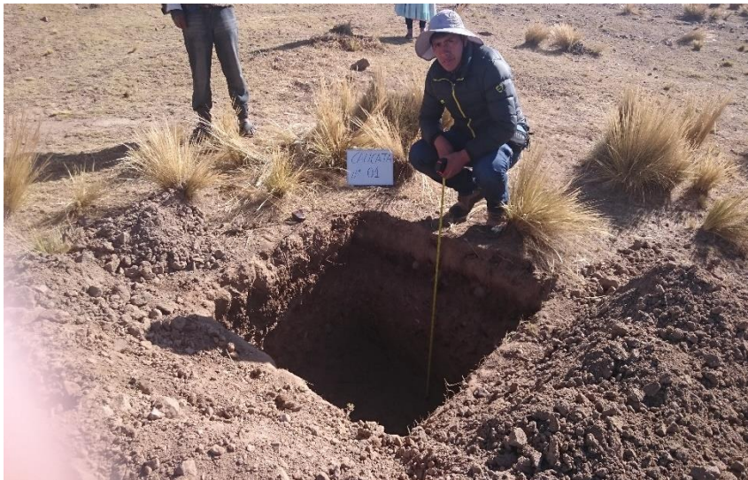
Figura 16. Excavación calicata N° 01
