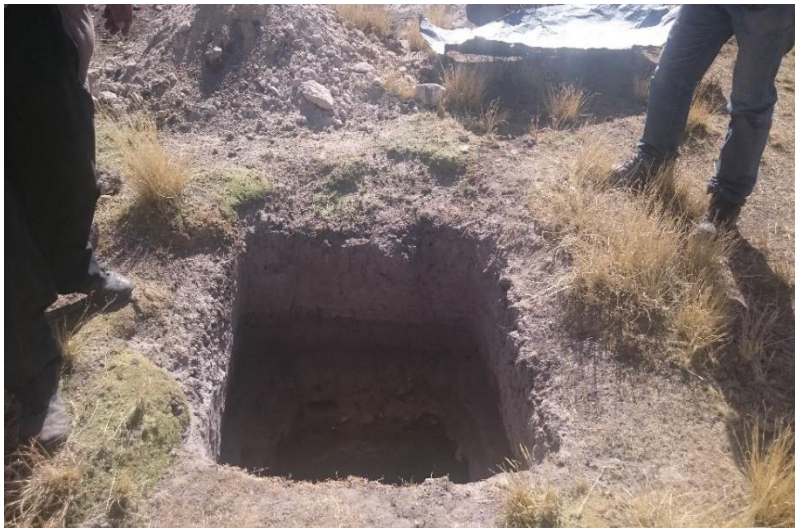
Figura 18.: Excavación calicata N° 03 – reservorio
