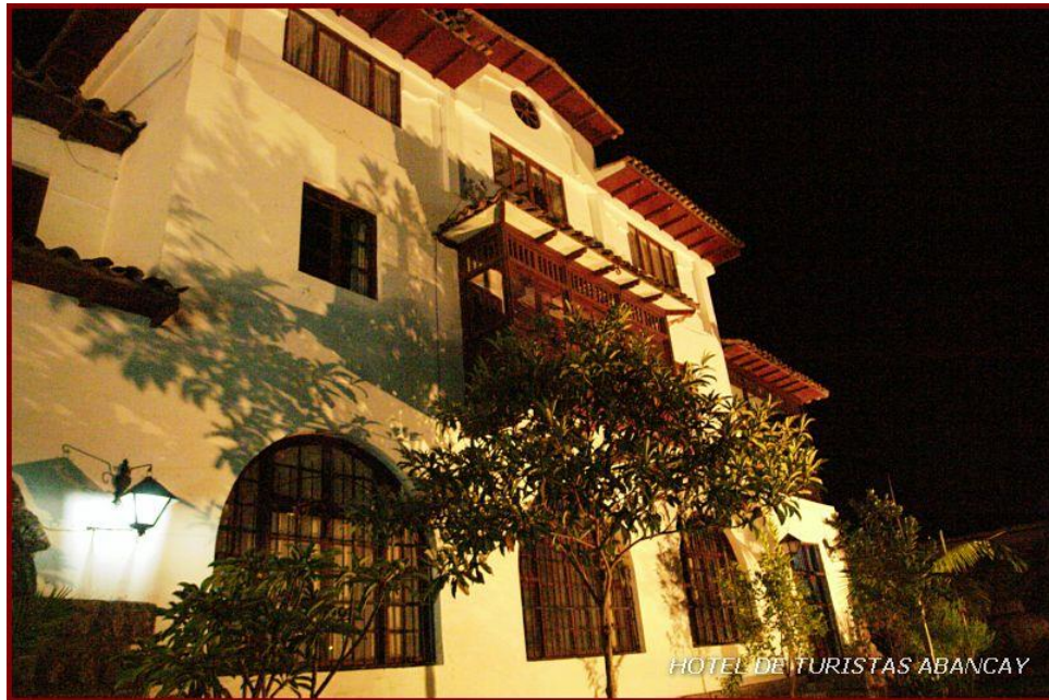
Imagen 1. Guillen, R. (2017, 12 de Noviembre) Frontis del hotel de turistas ABANCAY Fuente: Fotografía tomada por Rosmery Guillen Chacón , Abancay (2017)
