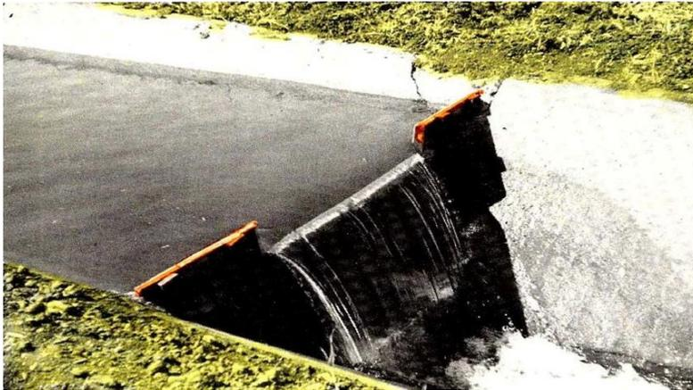
*Figura 7* Vertedero Sección rectangular
