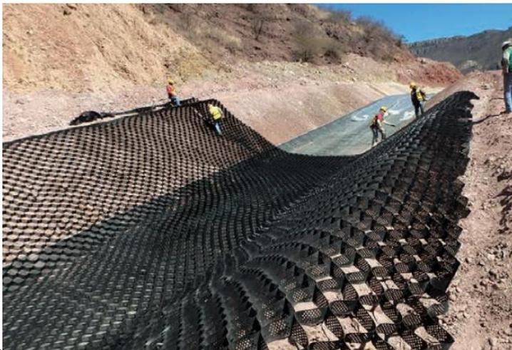
*Nota:* Geoweb - Soporte de Carga. Fuente: Geosystem 2016
