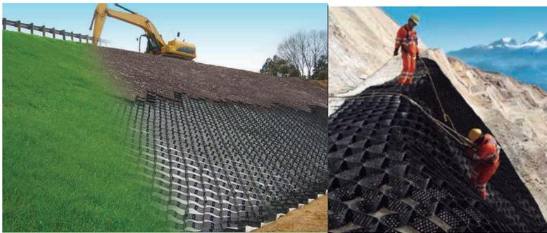
*Nota:* Geoweb - Soporte de Carga. Fuente: Geosystem 2016
