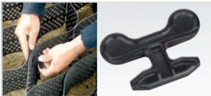
*Nota:* Geoweb, Protección costanera, ribereña y de taludes. Fuente: Geosystems (2019)
