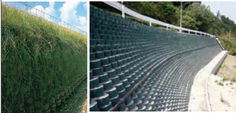
*Nota:* Geoweb - Soporte de Carga. Fuente: Geosystem 2016
