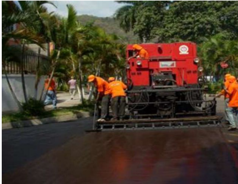
Figura 12. Lechada Asfáltica en vía urbana Fuente: Alonzo, 2012
