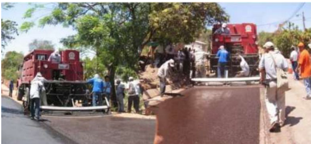
Figura 11. Lechada Asfáltica en camino rural Fuente: Alonzo, 2012
