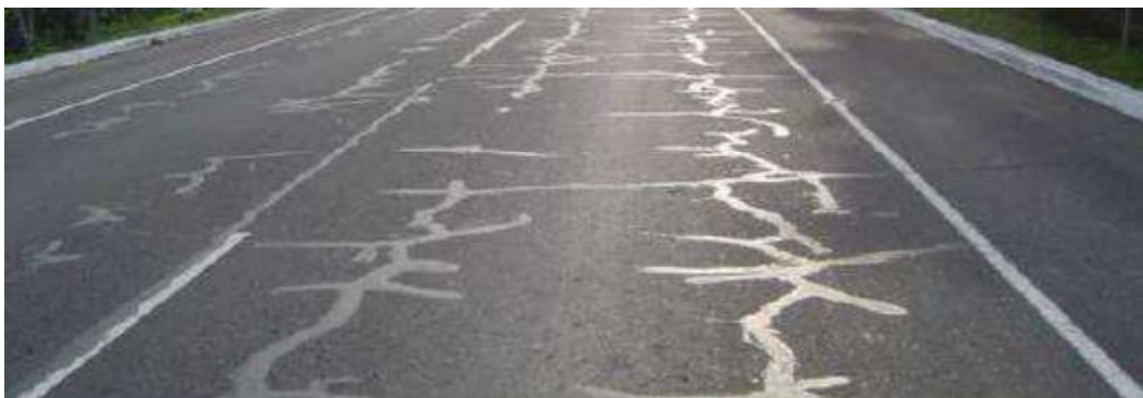
Figura 21. Acabado final del pavimento Fuente: Alonzo, 2012
