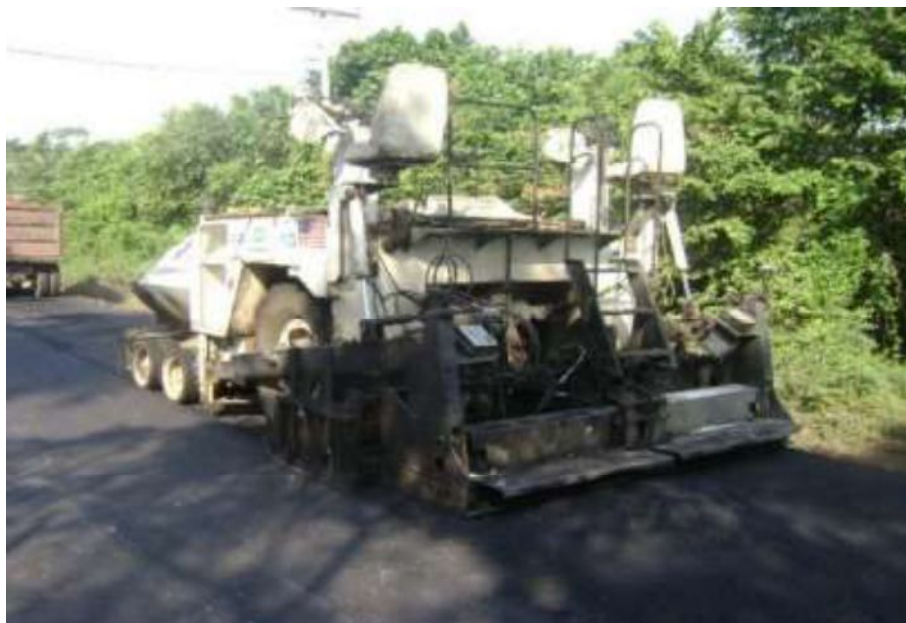
Figura 9. Colocación de mezcla asfáltica sobre riego de liga Fuente: Alonzo, 2012
