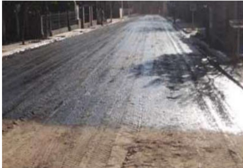
Figura 8. Riego de Imprimación Fuente: Alonzo, 2012
