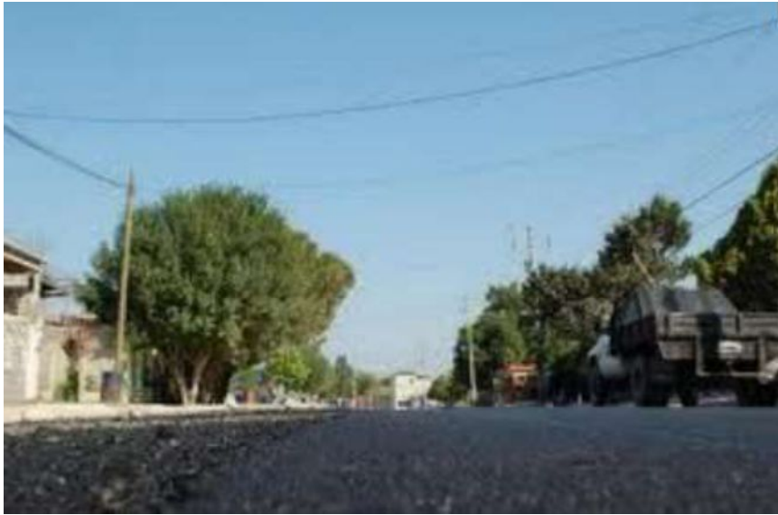
Figura 10. Riego de liga sobre riego de Imprimación Fuente: Alonzo, 2012
