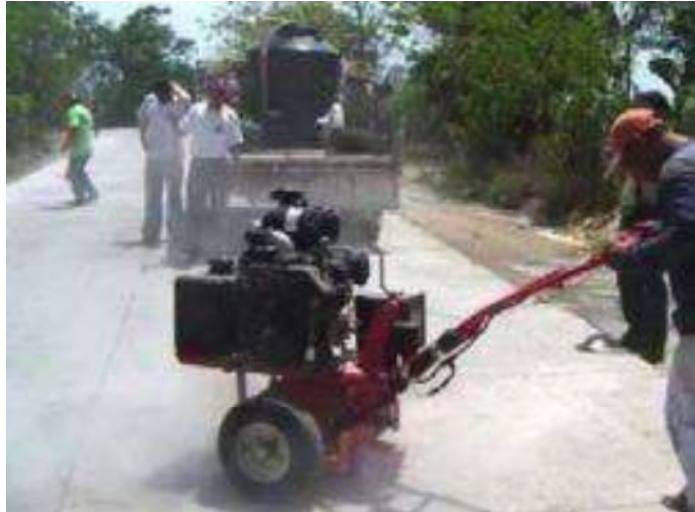
Figura 19. Ampliando la grieta o fisura con sierra mecánica Fuente: Alonzo, 2012
