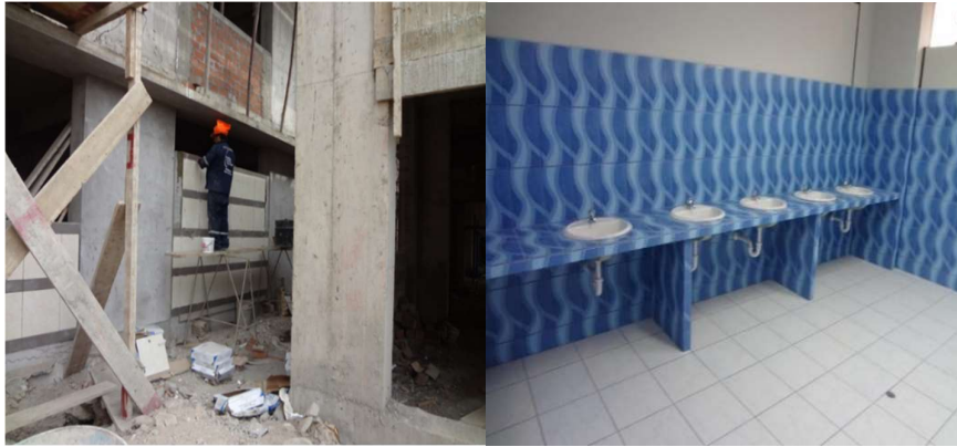
Instalación de Zócalos Cerámico Interior y Exterior
