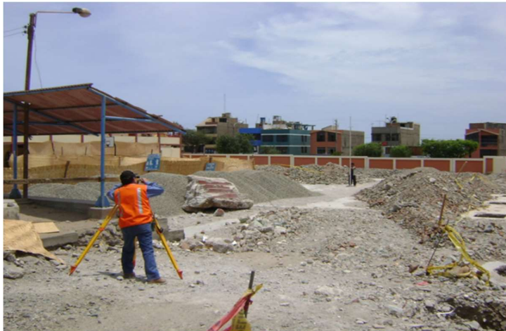
Trazo y Nivelación Topográfica
