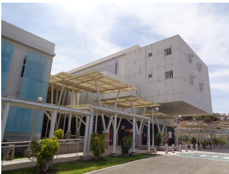
Figura 13 Área C del edificio hospitalario
