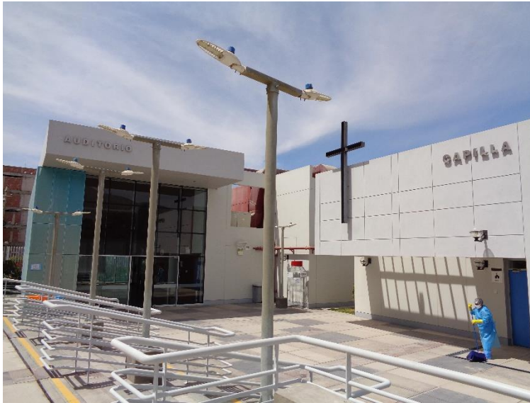
Figura 11 Área A del edificio hospitalario
