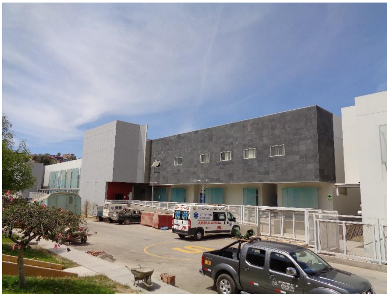
Figura 14 Área D del edificio hospitalario
