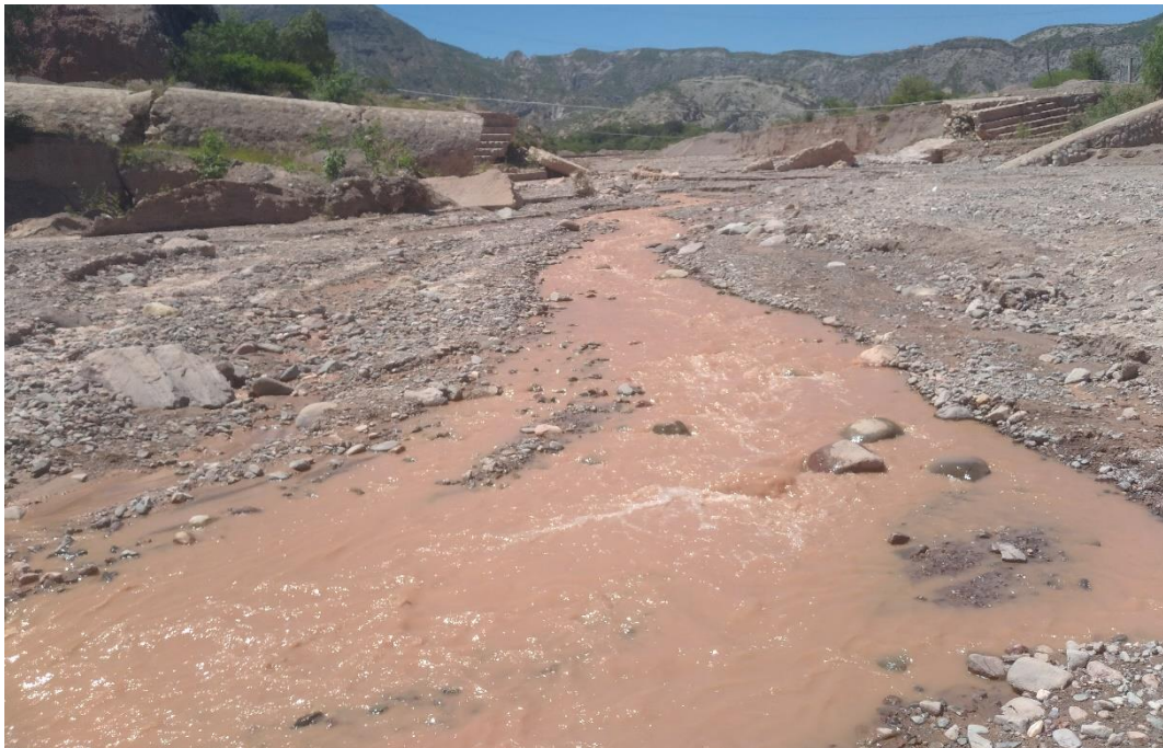
Figura 1. Cauce del río Chillico con estructura colapsada
