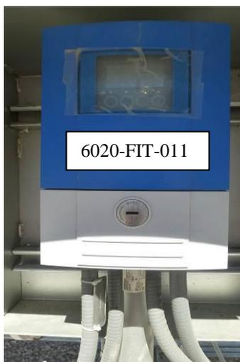
*Figura 8.* Caudalímetro 6020-FE/FIT-011” del desarenador área 2000
