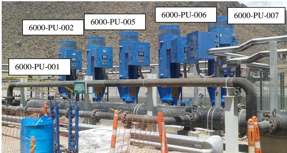
*Figura 9.* Bombas de impulsión 6000-PU-001/002/005/006/007
