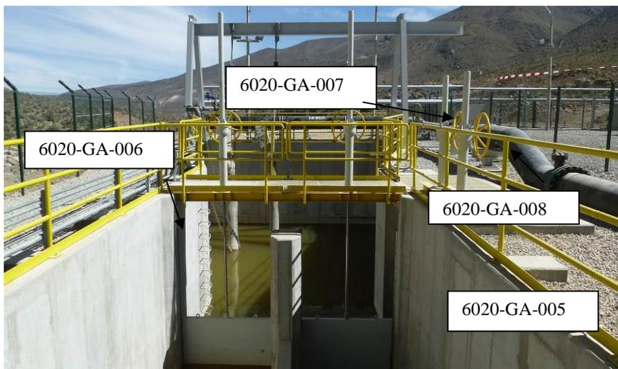
*Figura 5.* Compuertas de aislación salida y purga desarenador área 2000
