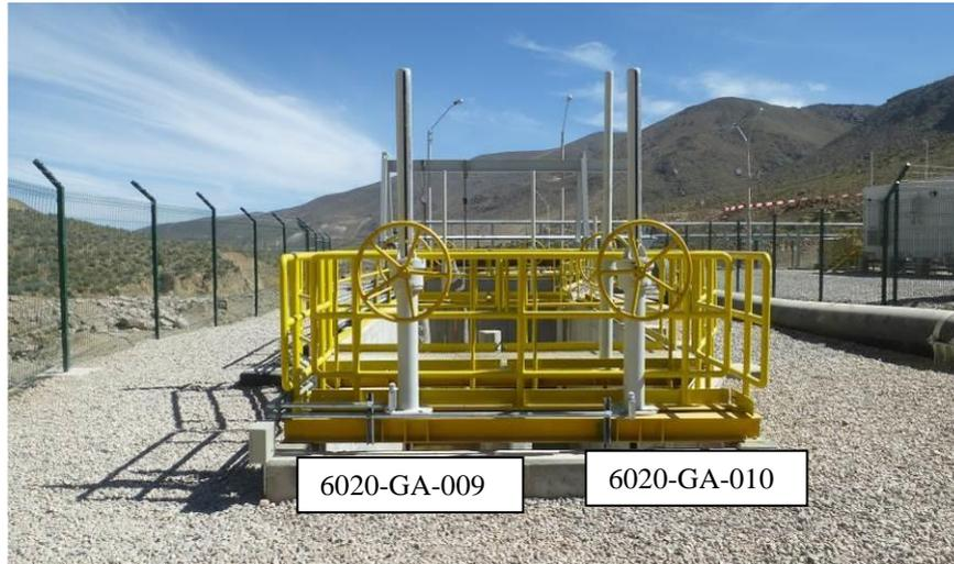
Figura 6. Compuertas reguladoras entrada desarenador área 2000
