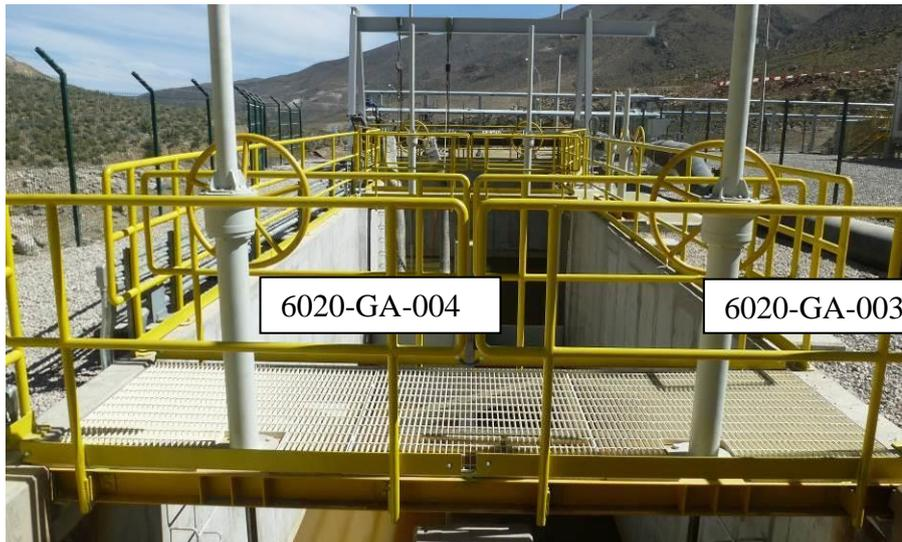
*Figura 4.* Compuertas reguladoras entrada desarenador área 2000
