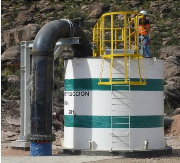
*Figura 12.* Tanque de Traspaso 6000-TK-001" (línea gravitacional)
