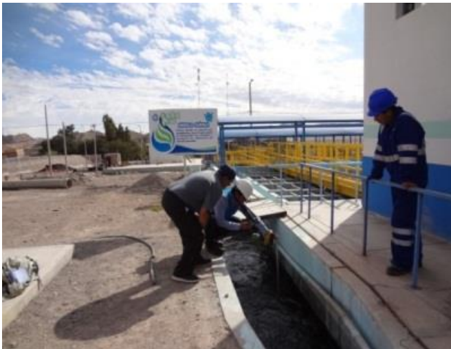
Figura 27. Midiendo la sub sección 1 del canal
