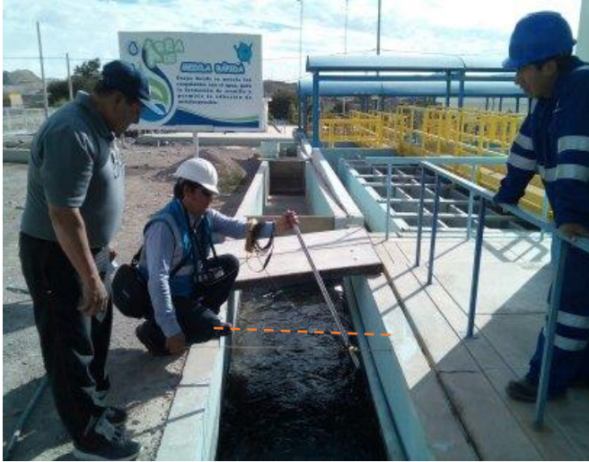
Figura 26. Medición de la sección del canal
