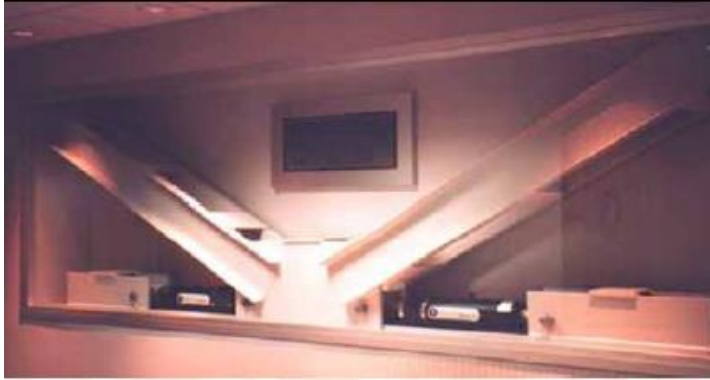
Figura 12. Configuración Chevron Brace Invertida
