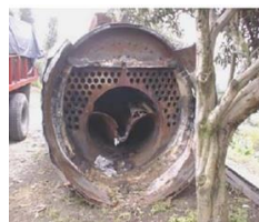
Figura 10. Implosión de calderas.
