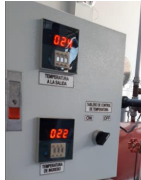
Figura 45. Pirómetro tanque Figura 46. Indicadores de temperatura del tablero.
