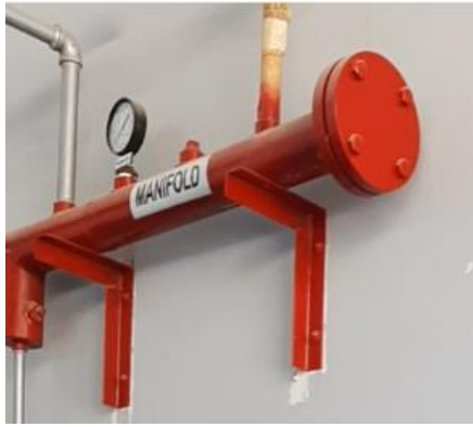
Figura 43. Presión de vapor en el manifold.
