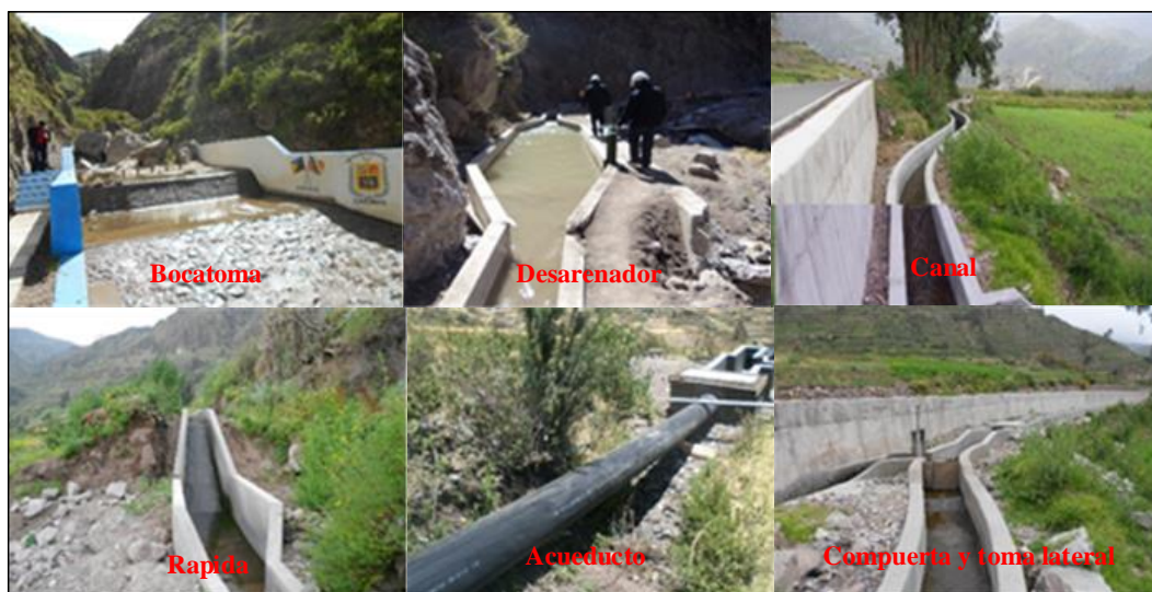
Figura 5. Componentes de la Infraestructura de riego menor
